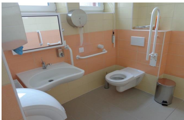
Rekonstrukce sociálních zařízení v budově školy
