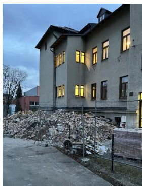
Budova školy-průběh akce
