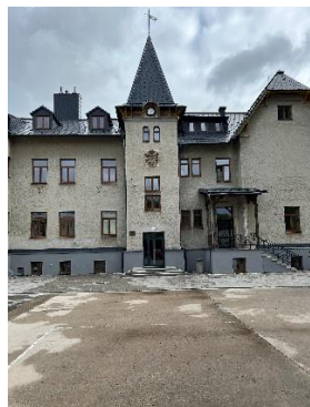
Budova školy – současný stav
