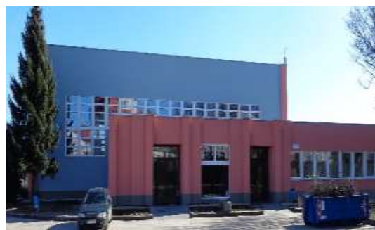
„Zateplení vybraných budov SŠZS“ - leden 2015
