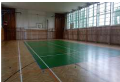
„Oprava dřevěné podlahy v tělocvičně“ - srpen 2015
