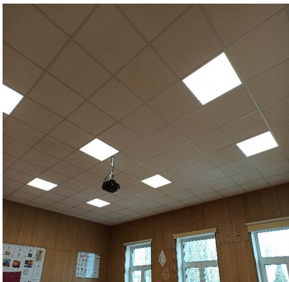
Učebna v 2.NP budovy školy
